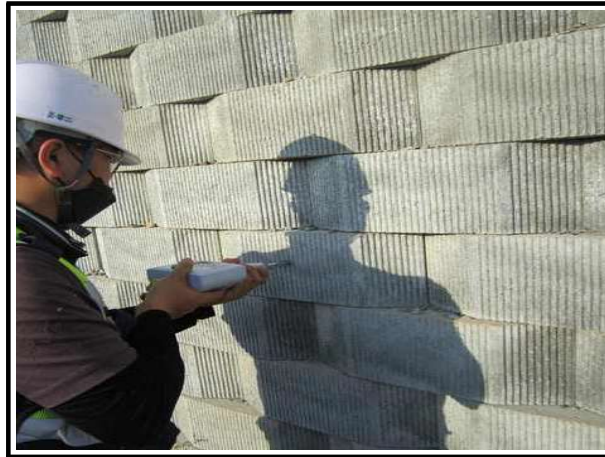
【그림 8.3.7】 슈미트해머를 이용한 반발경도시험 전경
